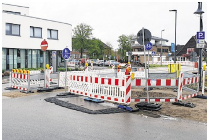
Der Helmut-Loose-Platz in Tungendorf wird in den kommenden Monaten umgestaltet. FOTO: LIPOVSEK
