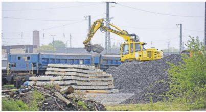
Auf dem Gelände des Terminals an der Brückenstraße sind bereits die Baumaschinen aktiv.
